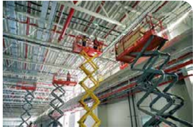
▲ Alles unter Strom: Insgesamt 150 elektrisch betriebene Arbeitsbühnen aus dem ecoRent-Portfolio von Zeppelin Rental unterstützen den Rück- und Neubau einer modernen E-Auto-Fertigungshalle der BMW Group in München – bei laufendem Betrieb. Mit den emissionsfreien Scheren- und Gelenkbühnen haben die parallel arbeitenden Gewerke flexiblen Höhenzugang von sechs bis 12 Meter Arbeitshöhe, dazu kommen elektrische Gabelstapler und Teleskoplader. Über eine taktgesteuerte Anlieferung und regelmäßige Sicherheitsprüfungen wird die permanente Einsatzbereitschaft gewährleistet. (Bild: action press Christian Rudnik)
