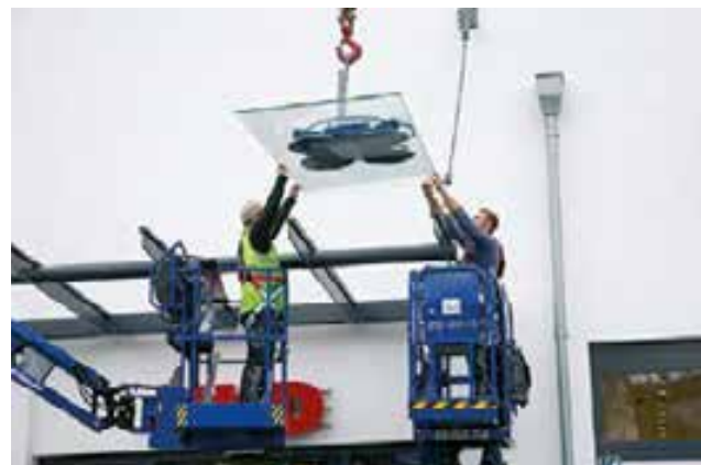
▲ Teamwork: Bei der Montage von Glasdächern an einem neu errichteten Fachmarktzentrum kamen mehrere Beyer Mietmaschinen zum Einsatz: Ein drehbarer Teleskopstapler TSR 2670, der die Glaselemente am Glas-sauger in Montageposition brachte, für die Monteure standen eine Sche-renarbeitsbühne SB 80 E und eine Teleskoparbeitsbühne TB 160 KD bereit, um in eine sichere und ergonomische Arbeitshöhe zu kommen. (Bild: Beyer)
