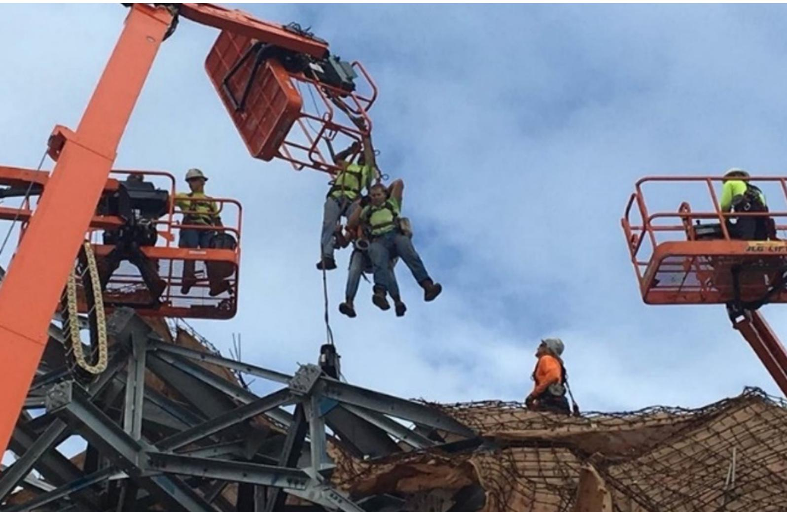
commandes au sol, soit en utilisant une autre PEMP appropriée. Lors de l'utilisation d'une PEMP pour récupérer la personne blessée, la plateforme doit (si possible) être placée directement en dessous de la personne afin qu'il n'y ait aucun risque qu'elle subisse une chute lorsqu'elle est libérée de son système de protection contre les chutes.
