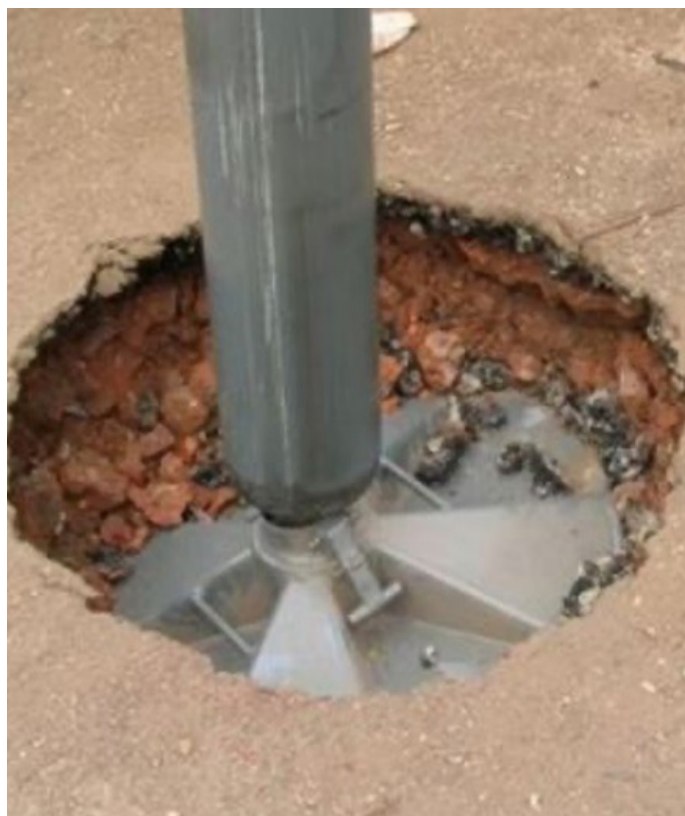
无撑杆板(地面剪力)的支腿脚示例。
