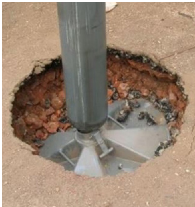
Voorbeeld van een stempelvoet zonder stempelplaat (grondverschuiving).
