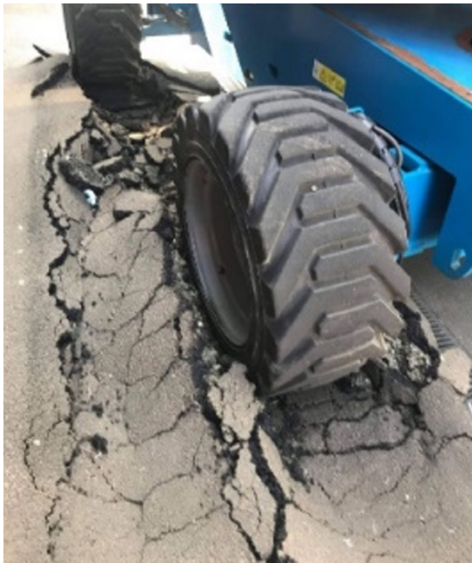
Voorbeeld van grondverzakking
