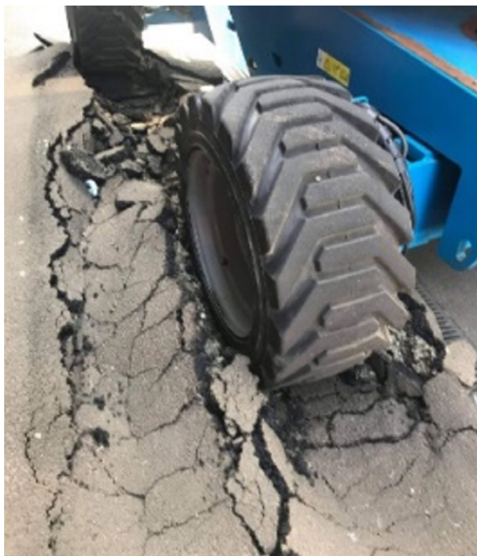
Esempio di affondamento del terreno
