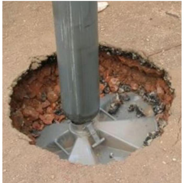
Ejemplo de una pata estabilizadora sin una placa de apoyo (cizallamiento del suelo).
