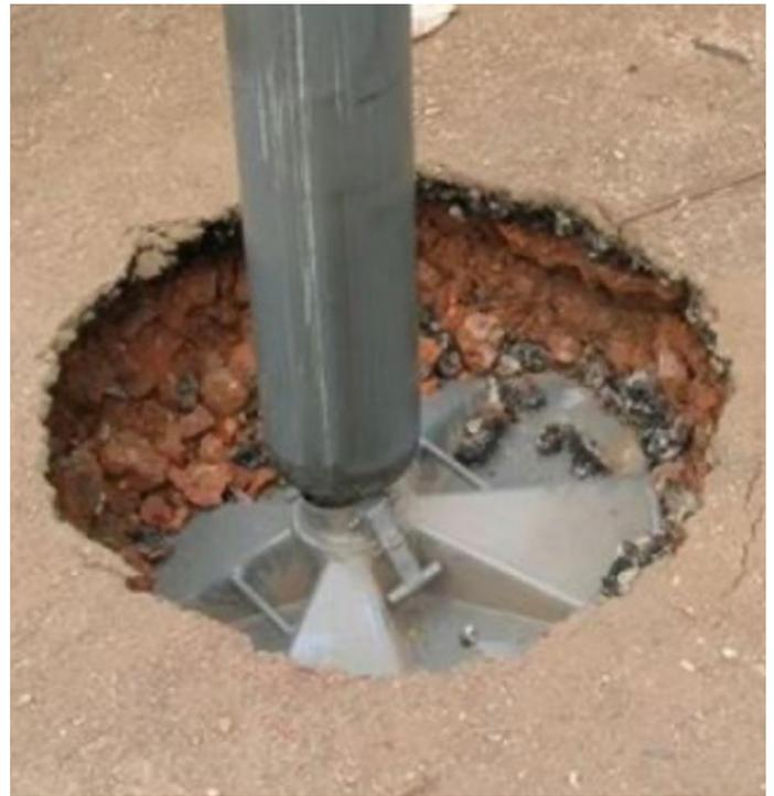
Beispiel für einen Stützteller ohne Unterlegplatten (Bodenschere).
