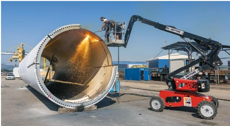
▲ **Elektroschrott:** Im Donauhafen von Krems in Niederösterreich wird der Stahlurm einer ausgedienten Windkraftanlage in transportfähige Stücke zerlegt. Mit Hilfe einer Manitou Mango 12 aus dem HKL-Mietpark schneiden Arbeiter die Turmsegmente per Schneidbrenner in bis zu acht Meter lange Stücke, anschließend gehen die bis zu vier Zentimeter dicken Stahlplatten direkt ins Recycling. (Bild: HKL)
