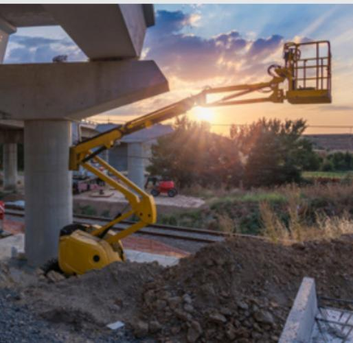
**切记:** 在收起位置行驶时也会发生弹射效应, 所以要确保人员在任何时候都穿戴连接到指定锚点的个人防护坠落保护设备 (PFPE)。在使用臂架式 MEWP 时, 人员必须始终使用全身式安全带和可调节的约束系索, 并尽可能调整到最短。
