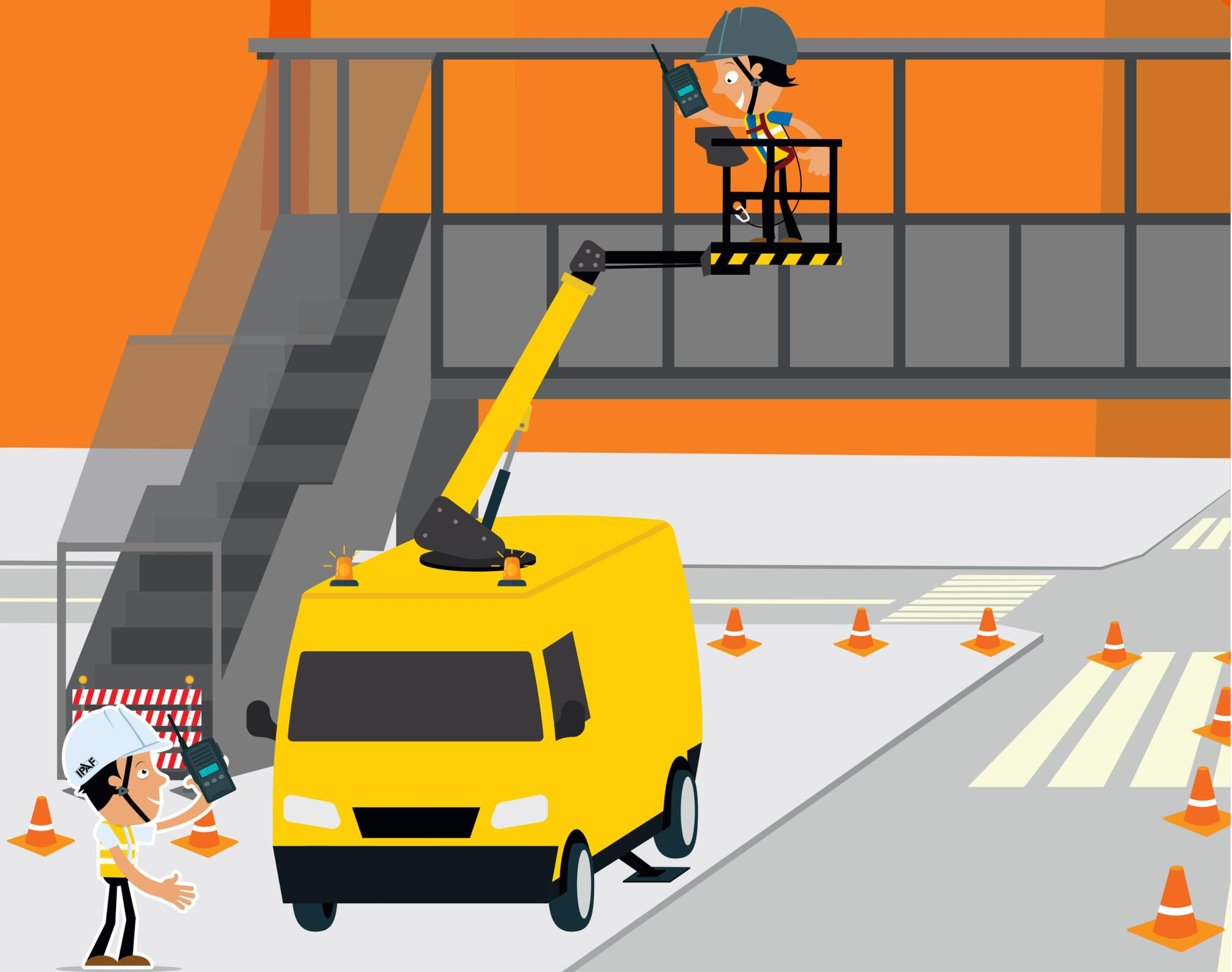
**TRABAJE SIEMPRE DE FORMA SEGURA Y ESTABLEZCA UNA ZONA DE SEPARACIÓN PARA EVITAR QUE EL BRAZO ENTRE EN UNA CARRETERA ABIERTA AL TRÁFICO**
